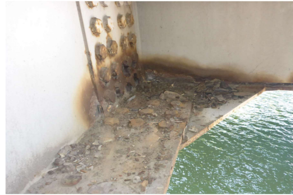
Corrosion feuilletée avec perte de matière sur un nœud de jonction
