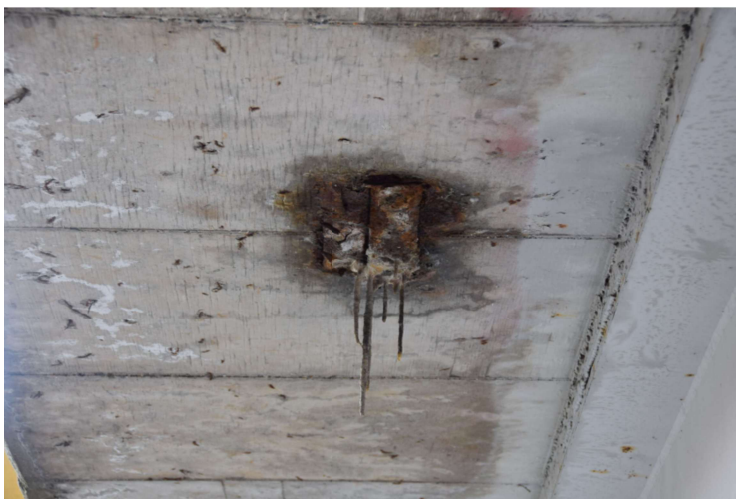
Tiges d'ancrages des platines de glissières de sécurité avec corrosion feuilletée et stalactites
