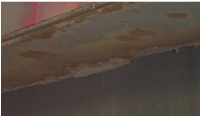
Corrosion feuilletée de la membrure inférieure de l'entretoise d'about
