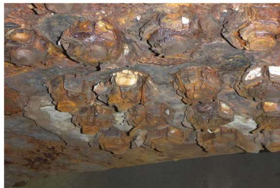
Corrosion feuilletée de la platine de jonction et des boulons
